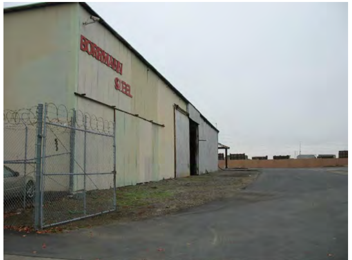
BORMANN STEEL-2450 PULGAS AVENUE
