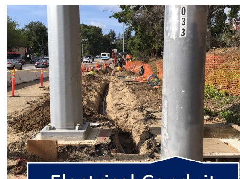
Electrical Conduit Installation
