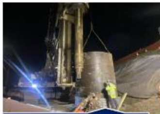
Colocación de la carcasa de acero permanente
