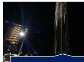
Jaula de barras de refuerzo preparada para el fraguado
